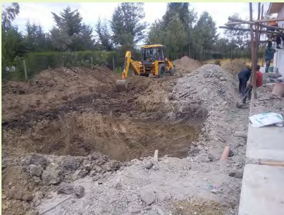
Excavation works Kajiado Maisonette
